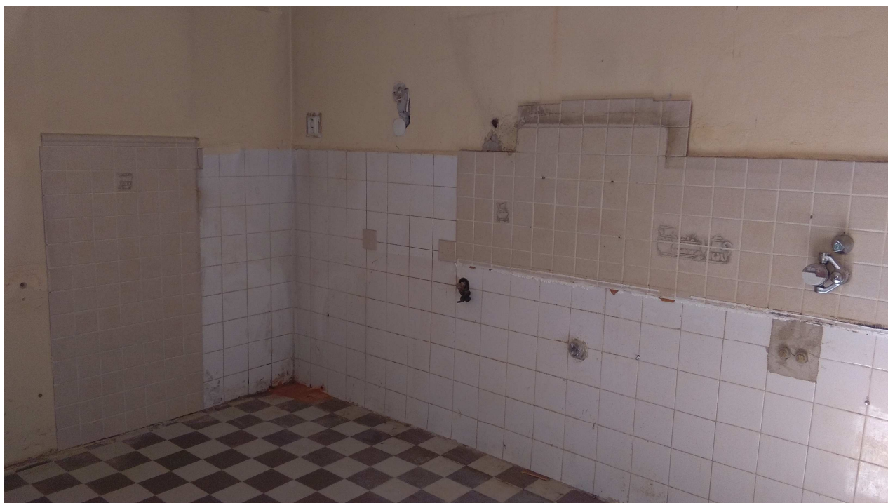
Obr. č. 13 – Kuchyně – původní dlažba 15x15 cm
