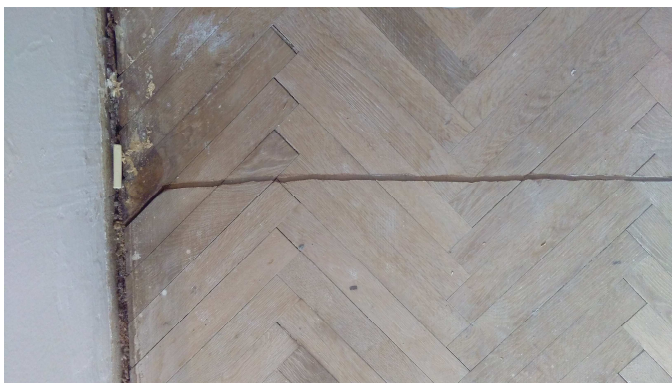
Obr. č. 10 – Podlaha chodby – poškození vlysů
