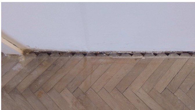
Obr. č. 11 – Podlaha chodby – chybějící lišty
